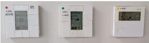
左側：空調機／中央：全熱交換器；常時、全館換気をしています。手元でのon/offはできません。強弱の調整のみできます。／右側：全館加湿器；手元でon/offができます。このほかに床置き型の加湿器も適宜使用しています。
